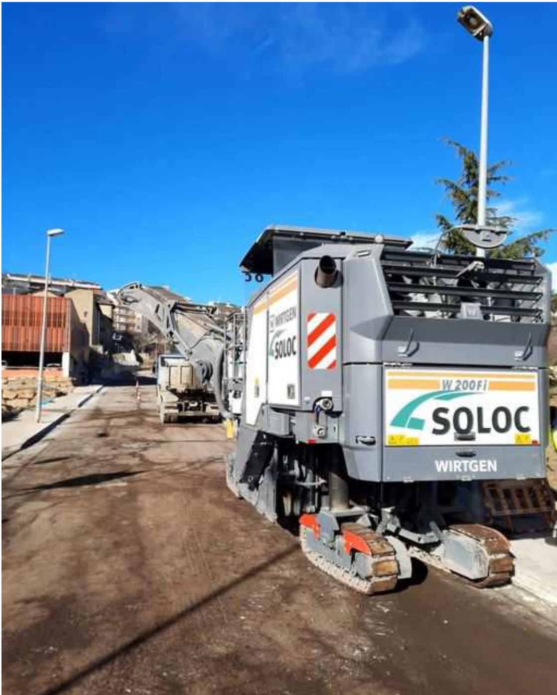
Obres de renovació del ferm de diversos carrers del barri de l'Incasòl de Puigcerdà / puigcerda.cat
