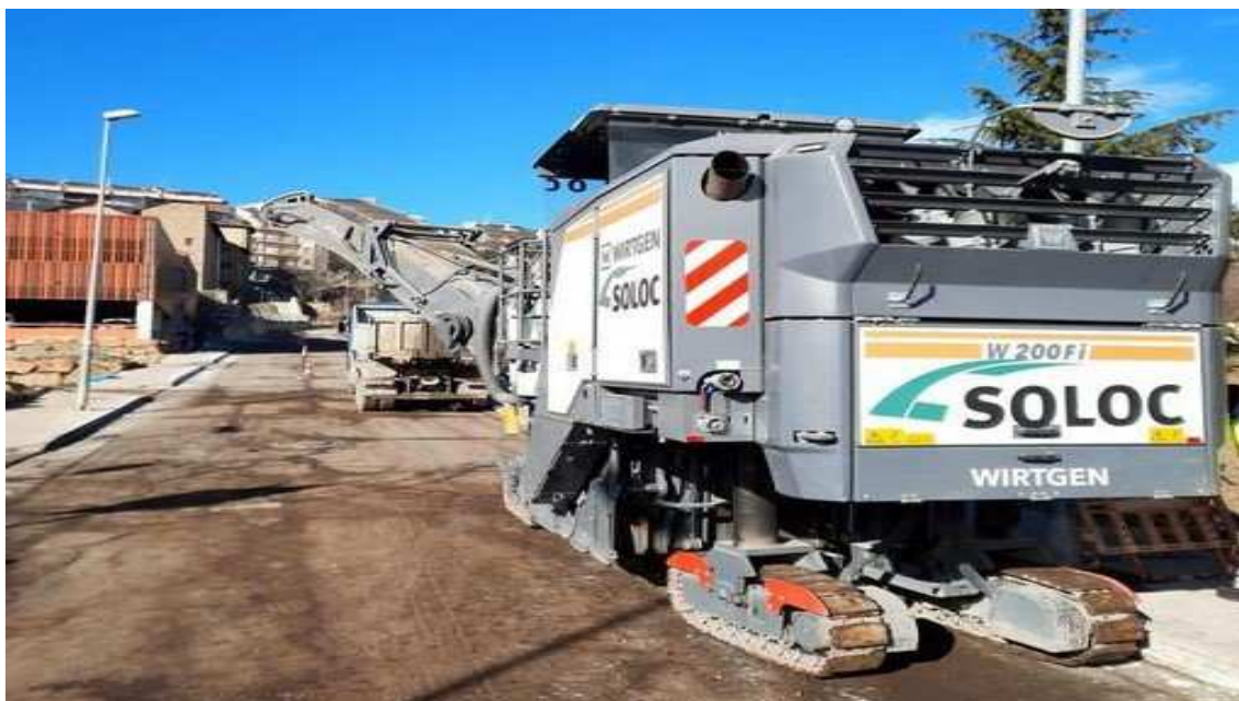
photo_camera Obres de renovació del ferm de diversos carrers del barri de l'Incasòl de Puigcerdà / puigcerda.cat
