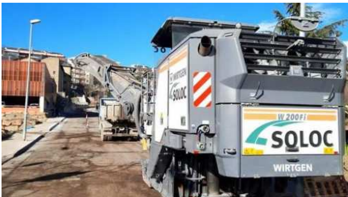
Obres de pavimentació de l barri de l'Incasòl | Ajuntament de Puigcerdà
