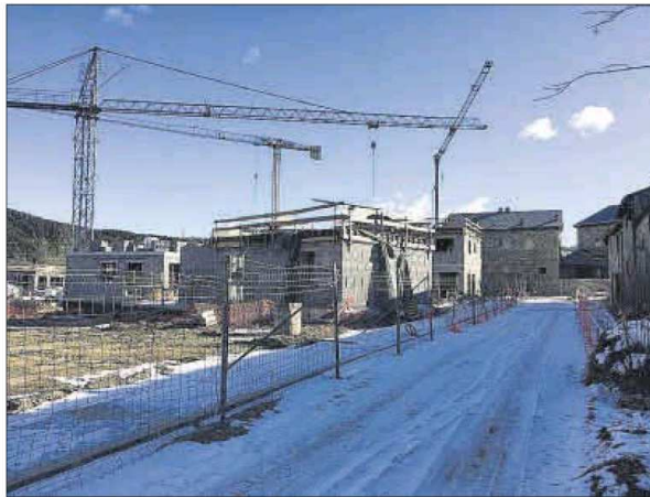
La pleta que s'està construint al Riu de Santa Maria
