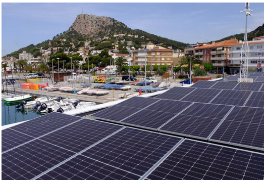
El sostre d'un edifici del port nàutic de l'Estartit amb plaques solars ACN.
