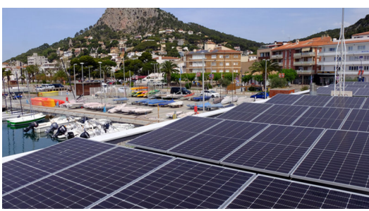
Instal·lació de plaques solars en el Club Nàutic Estartit EPA.
