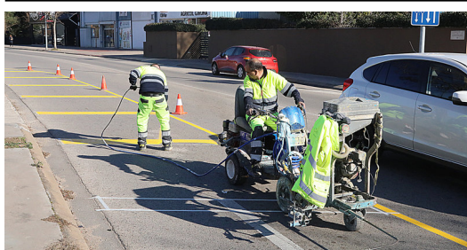
Operaris treballant en la senyalització de les obres MANEL LLADÓ.
