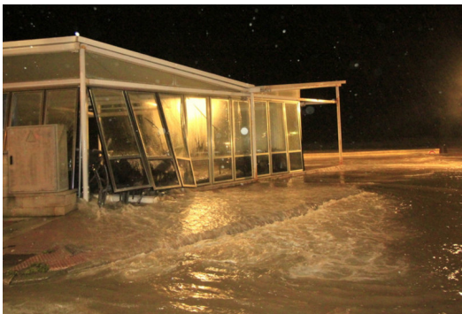
Restaurant del Passeig de Blanes afectat per una onada AJUNTAMENT DE BLANES.
