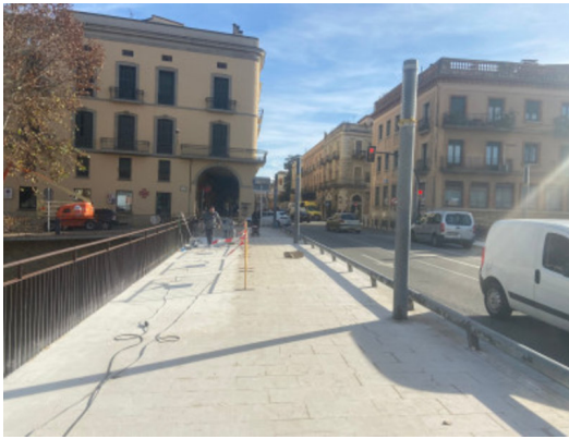
El pont nou del la Bisbal, durant els treballs J.T.
