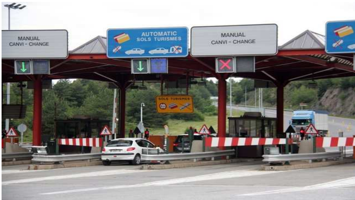
Peatge del Túnel del Cadí, a la carretera C-16, al tram de la Cerdanya / ACN
