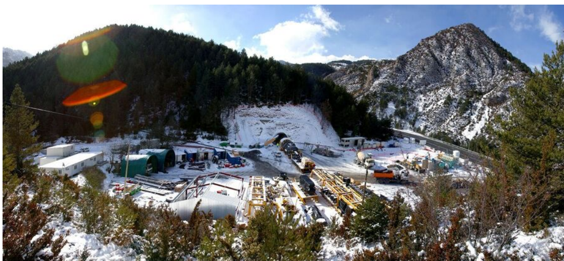
Construcción del túnel del Cadí en 1984
