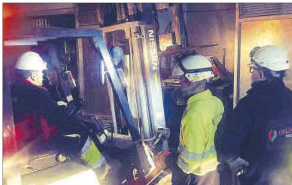
Les tasques de substitució de l'antic transformador
