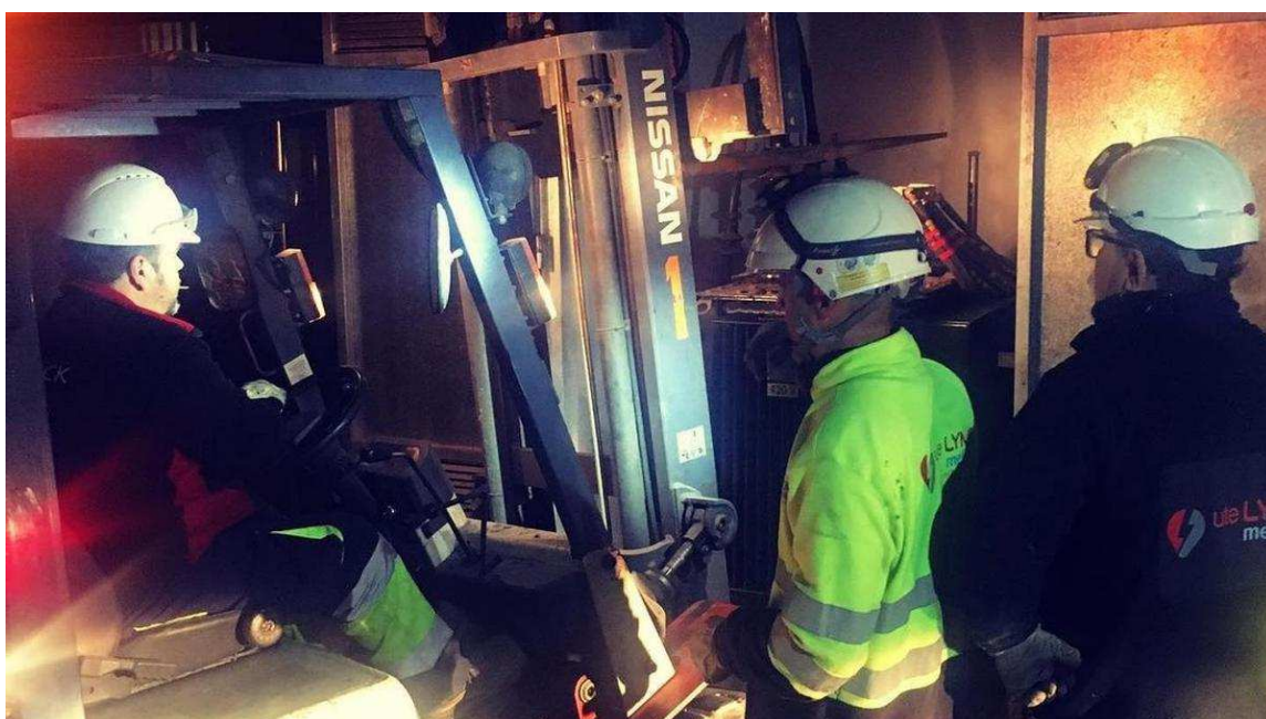
Les tasques de substitució de l'antic transformador AJ PUIGCERDÀ
