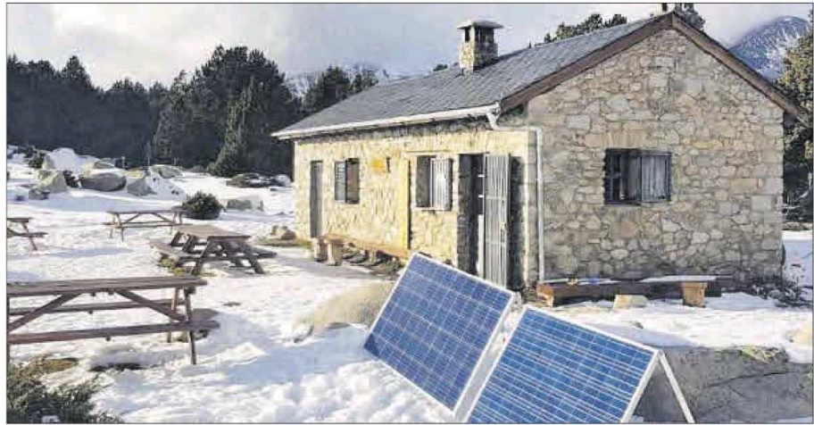
El refugi de la Feixa amb plaques solars provisionals aquest mes de desembre
