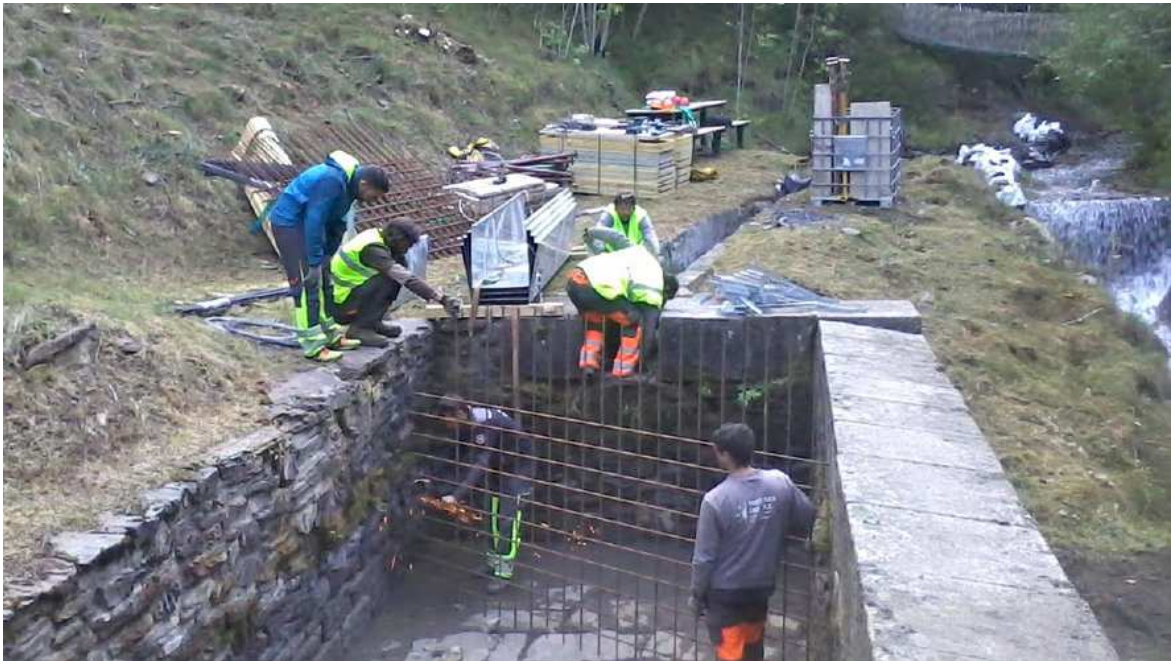
Les ouvriers menant l'étanchéification du bassin de décantation du canal d'Err.
