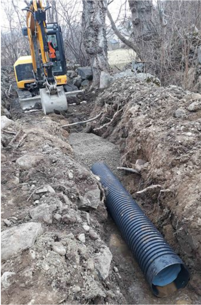
Le busage et enfouissement du canal du Ribéral d'Angoustrine.
