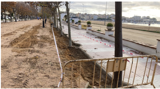
Treballs per eliminar un tram d'un canal de recollida d'aigües, ahir al matí. S. J.T.
