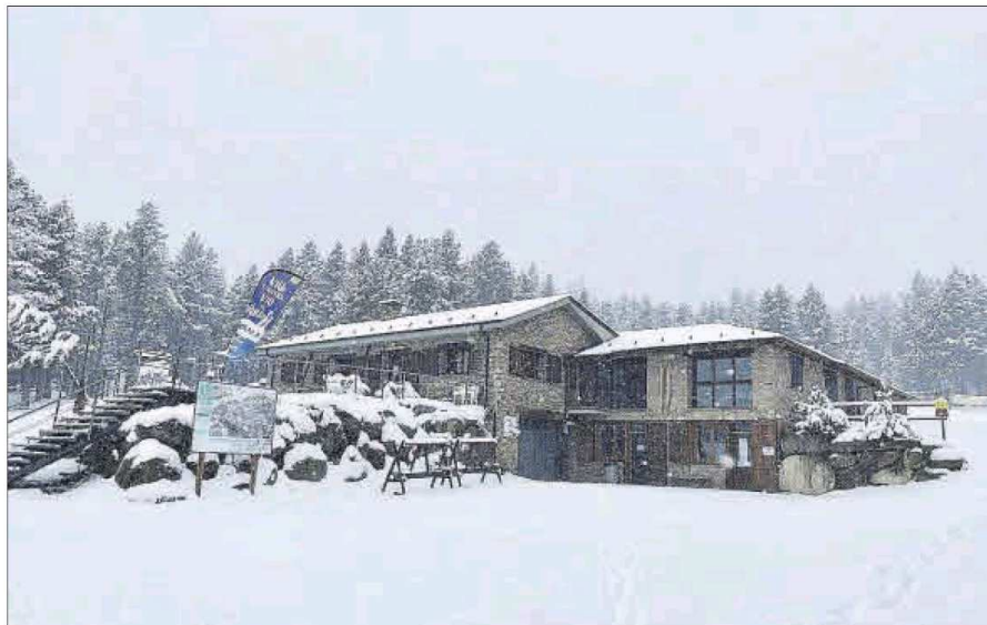
L'edifici de serveis de l'estació d'esquí d'Aransa, al municipi de Lles
