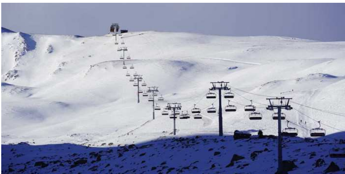
El nou desembragable de 6 places de Poma ja es troba en la fase de proves tècniques
