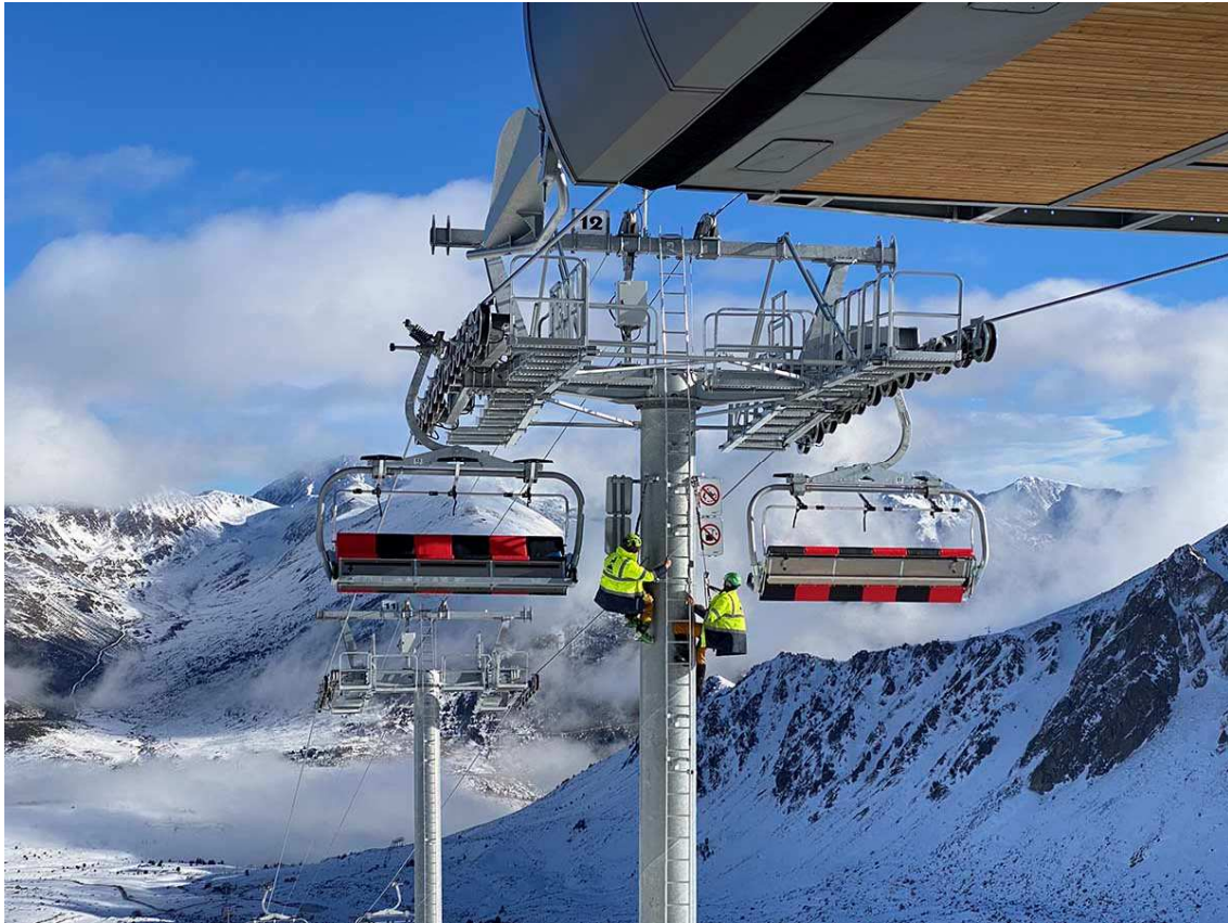
Darreres tasques de treball i posada a punt del nou telecadira Dôme de la Mine de Porté Puymorens (Foto: DDLN)
