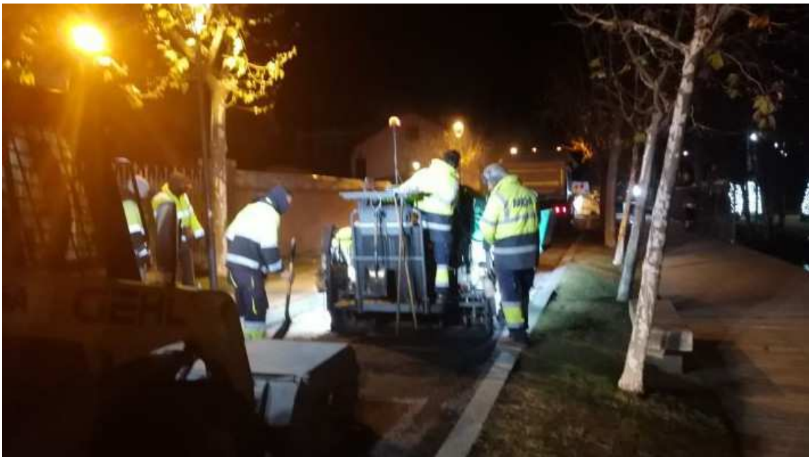
Operaris treballant en la pavimentació aquesta tarda | Maria Sans
