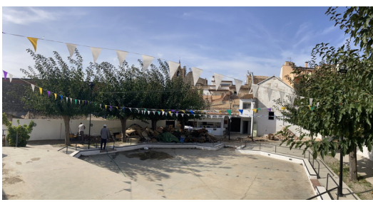
L'espai del darrere del Cercle Calongí, on es treballa en el marc d'una nova plaça J.T.
