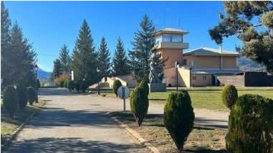
Aeròdrom de Cerdanya | Aeroports de Catalunya
