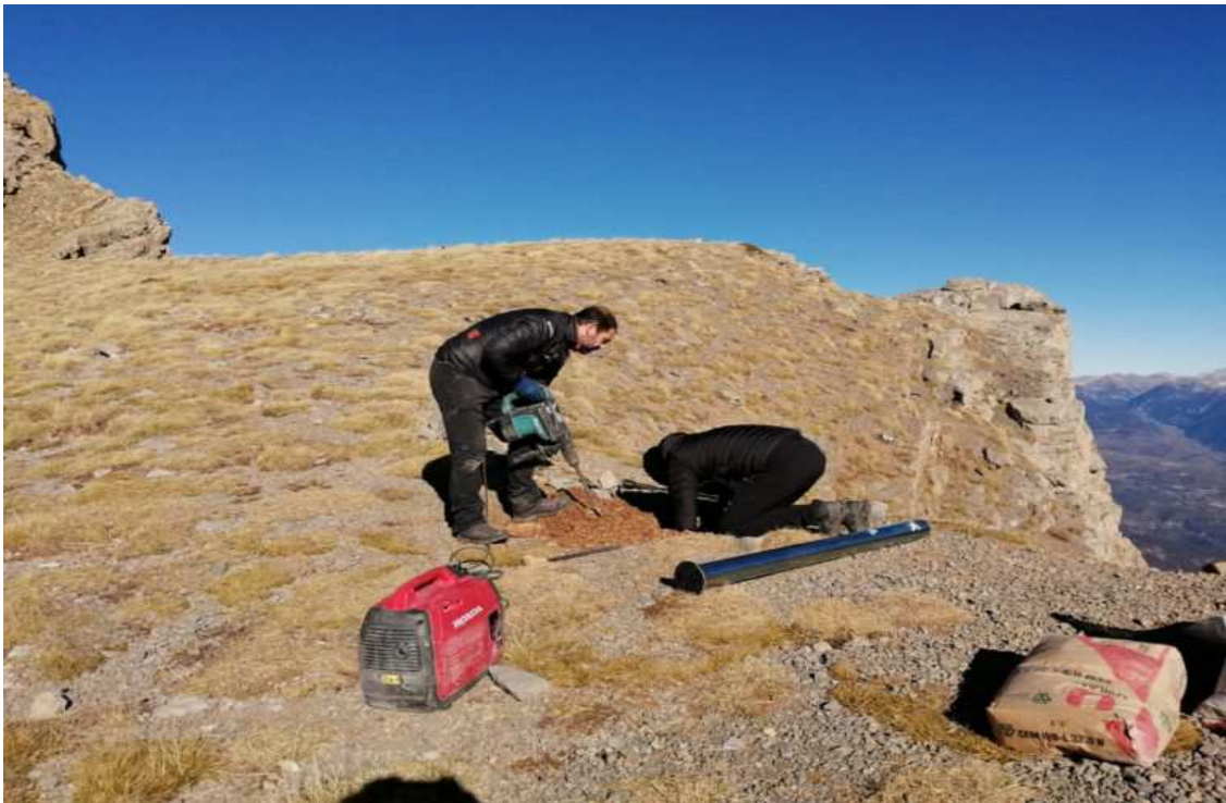
Instal·lació del nou ancoratge a la canal del Cristall. / PNCM
