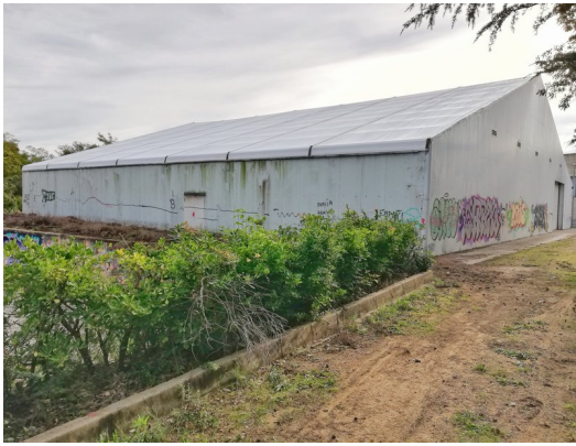
La nova coberta de la nau dels carrossaires J. TRILLAS.
