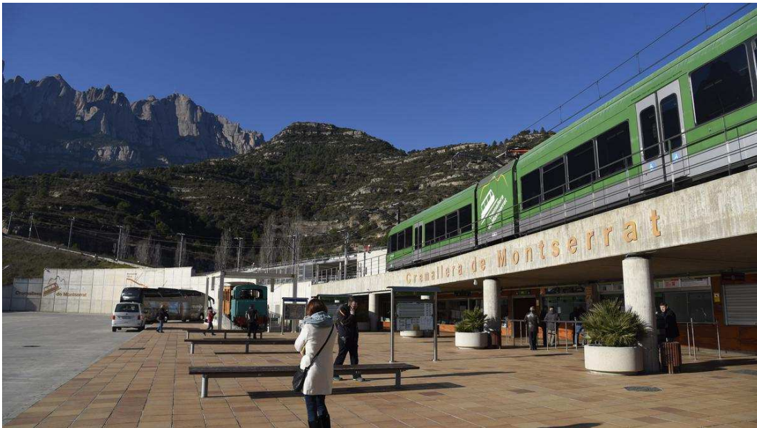
Instal·lacions de l'estació de Monistrol Vila ARXIU/MIREIA ARSO
