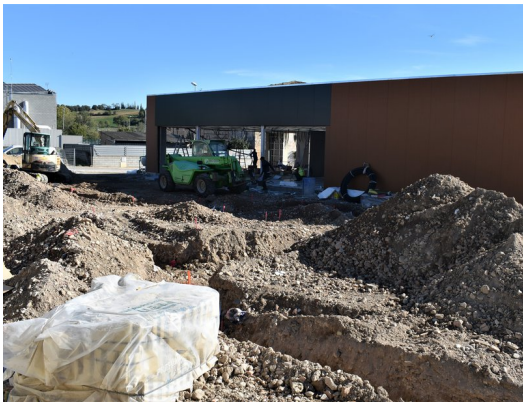
Les obres del nou establiment de l'avinguda de la Farga, ahir al matí R.E.
