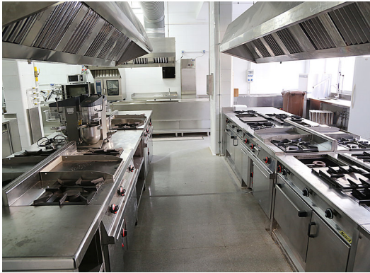
Instal·lacions d'hostaleria al centre de l'avinguda Roca Grossa de Lloret. M.LL.
