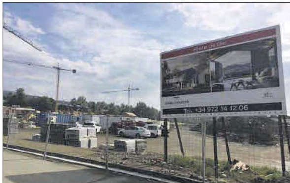
Una construcció de segones residències a Ger
