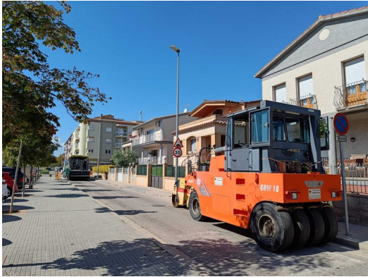
Obres a la vorera del carrer Folch i Torres AJUNTAMENT DE SALT.
