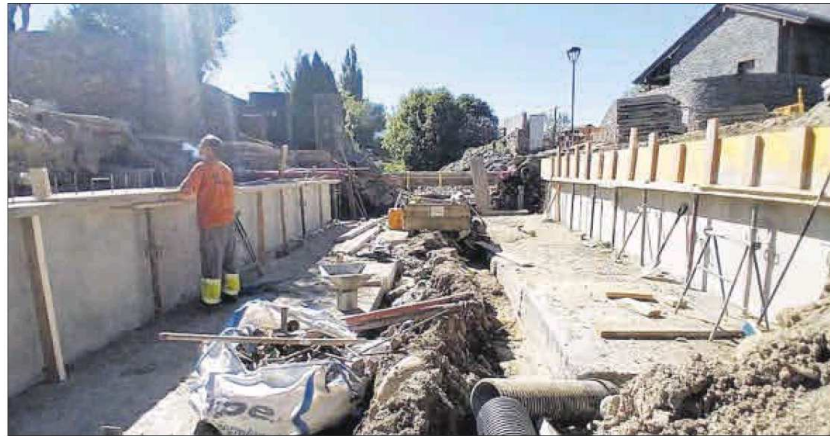
Les obres de condicionament del torrent dels Agustins al seu pas pel centre de Bolvir
