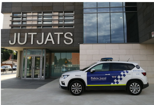
La façana de l'edifici dels jutjats amb un cotxe de la Policia Local aparcat ACN.
