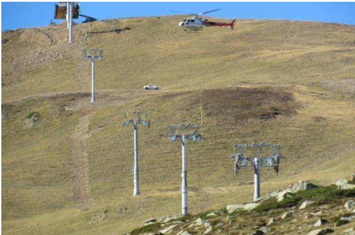
El helicóptero de Heli Austria instalando las pilonas del nuevo telesilla. (Foto: stationsdeski)
