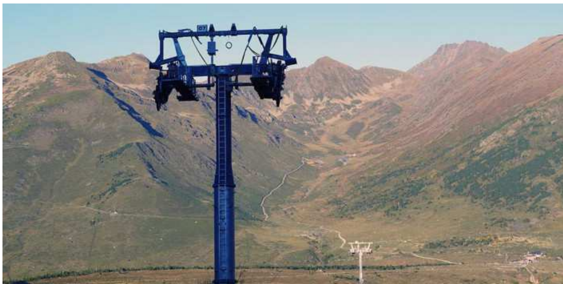
De visita a les obres del nou telecadira de Porté Puymorens
