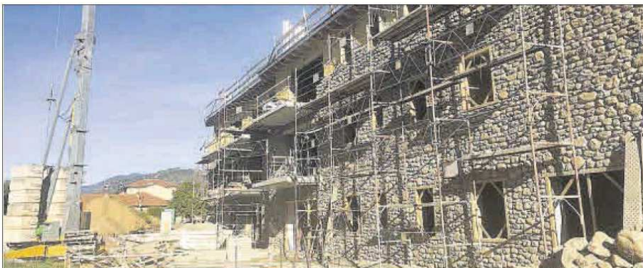
Un edifici a mig construir al veïnat del Pla de Tomet de Bellver
