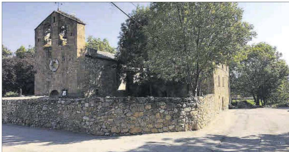
L'edifici de l'antiga rectoria on l'Ajuntament vol fer quatre habitatges socials
