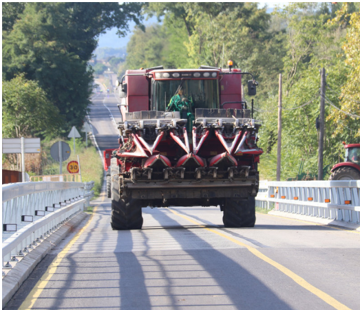
Imatge d'un camió passant pel pont de Verges i invadint el carril contrari ACN.
