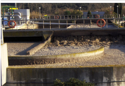
La depuradora de la Bisbal d'Empordà. ACN.
