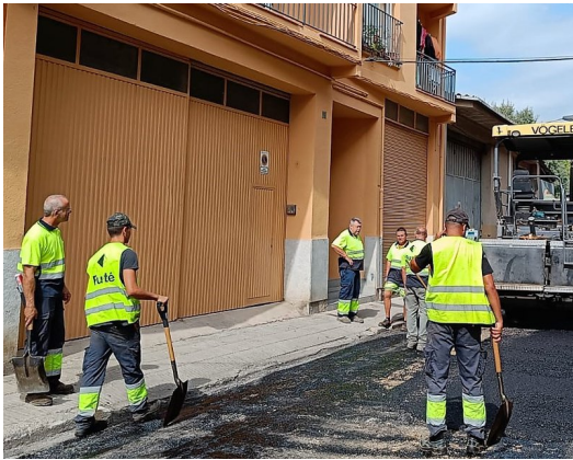
Treballs d'asfaltatge al carrer Jacinto Benavente de Salt AJUNTAMENT DE SALT.
