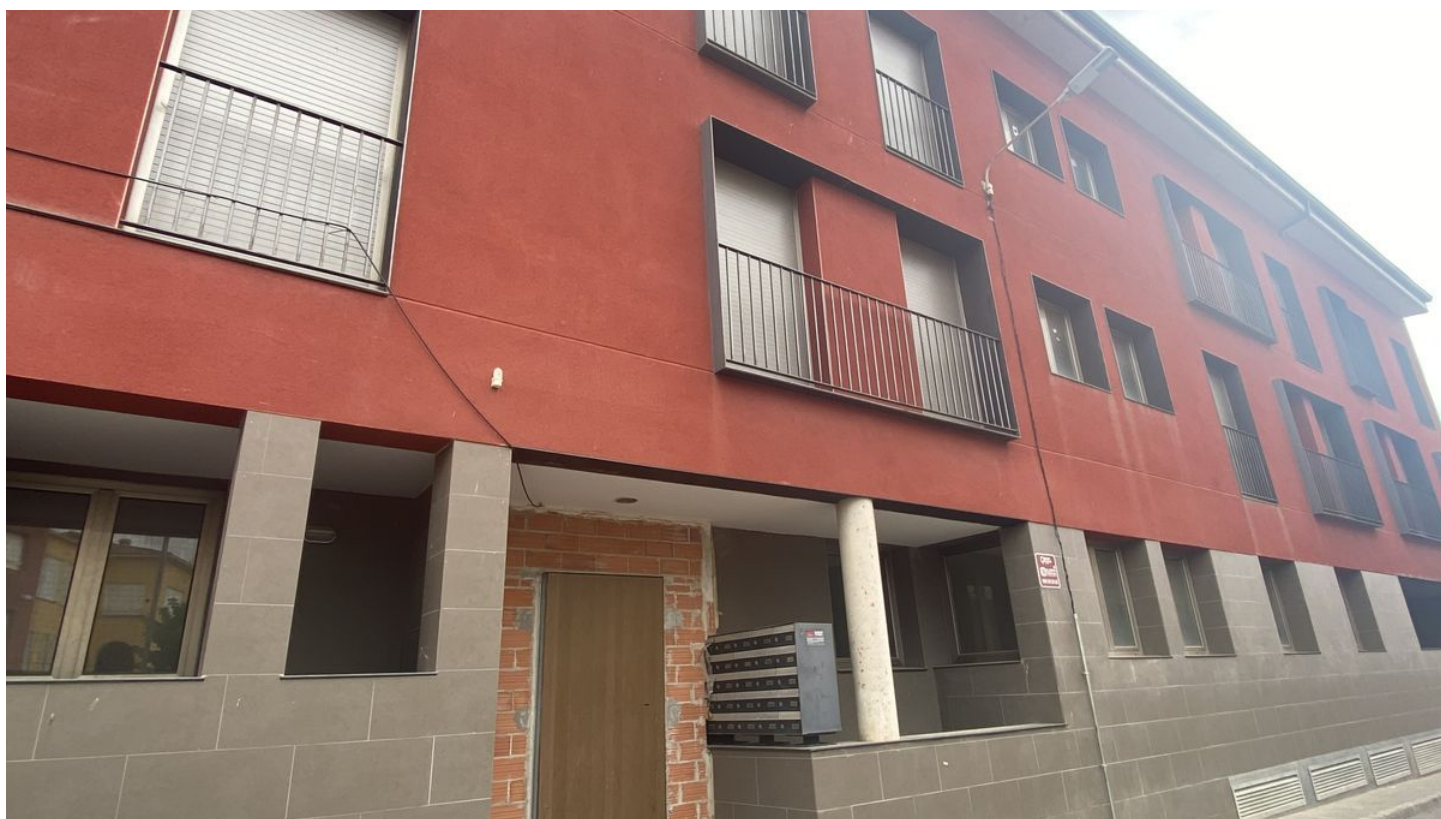
El bloc de pisos ocupat es troba al carrer Girona de Caldes de Malavella / AJUNTAMENT DE CALDES
