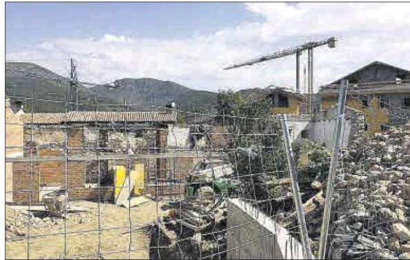
Una urbanització en construcció a Bellver de Cerdanya
