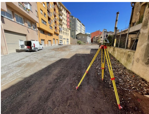
Imatge del terreny abans de les obres | Ajuntament de Ripoll
