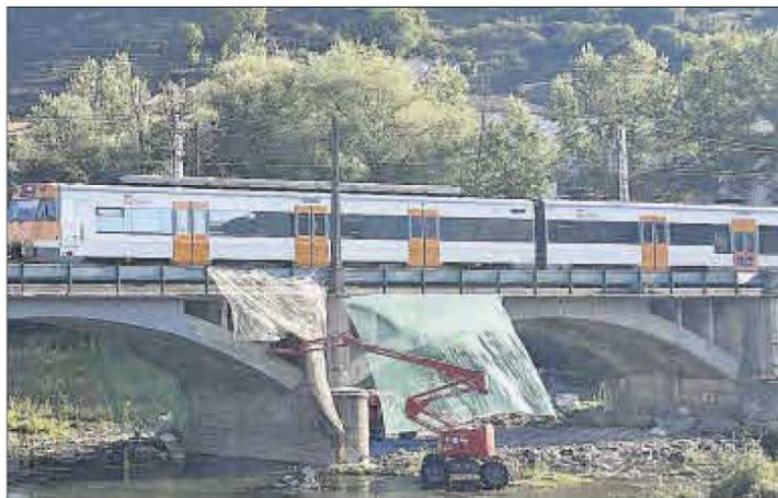
El tren passant pel pont on s'han fet les obres
