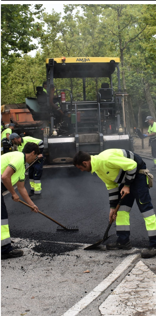
L'asfaltatge de prova fet el setembre de l'any passat al passeig Dalmau R.E.
