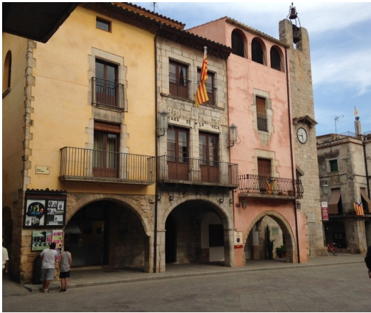
Façana de l'ajuntament de Torroella de Montgrí, en una imatge d'arxiu JOAN PUNTÍ.
