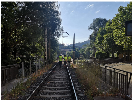
Operaris sobre el pont del tren de Ripoll | Arnau Urgell
