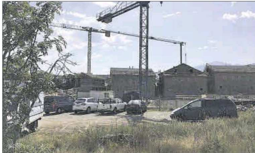
Un veïnat nou en construcció a Riu de Santa Maria
