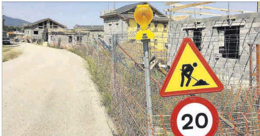
Un edifici en construcció en un dels veïnats en creixement de Bellver de Cerdanya
