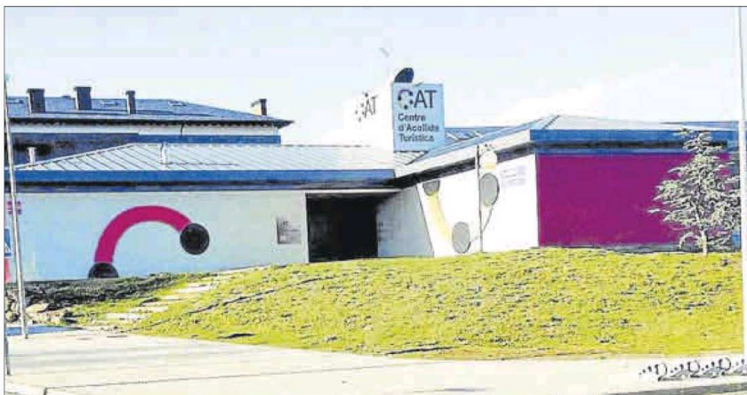
L'edifici de l'antic Centre d'Accollida Turística que ha d'albergar el nou DARP
