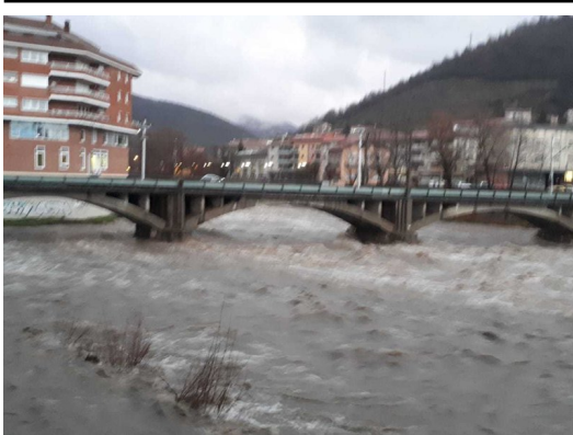
El pont ferroviari a l'aiguabarreig del riu Ter i Freser, que han contribuït a la degradació J.C.
