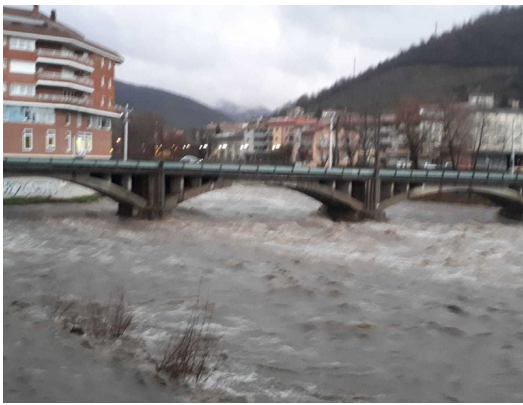
El pont ferroviari sobre el riu Ter J.C.
