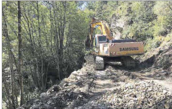
Una excavadora repara les esculleres de l'Inglà
